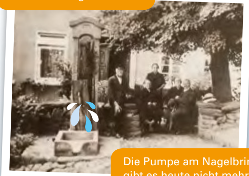
Das Vlothoer Wasserwerk wurde 1928 an der Weserstraße Nr. 50 gebaut.
