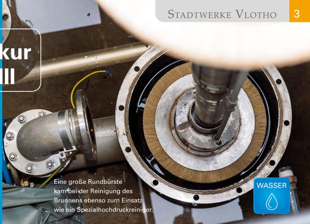
Eine große Rundbürste kam bei der Reinigung des Brunnens ebenso zum Einsatz wie ein Spezialhochdruckreiniger.
