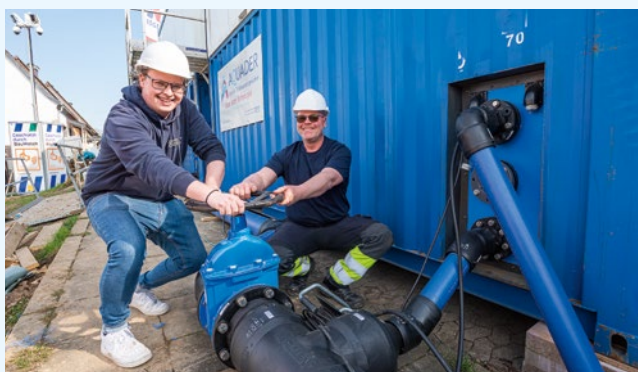
Netzmeister René Apel (l.) und Olaf Himmelreich zeigen vollen Einsatz am mobilen Trinkwasserspeicher.
